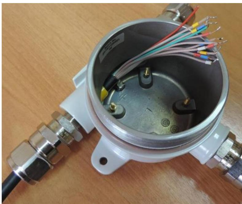
Рисунок Д.4 – Коробка ККВ14 с кабелем (кабель показан для примера)
